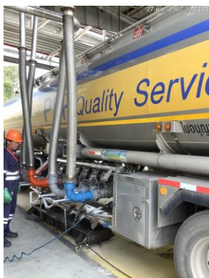
ภาพที่ 3.4.4-1 เครื่องควบคุมไอระเหยน้ำมัน (Vapor Recovery Unit : VRU)
