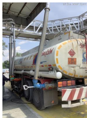
ภาพที่ 3.4.4-1 เครื่องควบคุมไอระเหยน้ำมัน (Vapor Recovery Unit : VRU)
